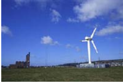
Tuuli- ja hiilivoimalaitos
